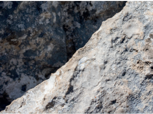
Risse und Schuppen in der Ostwand.
